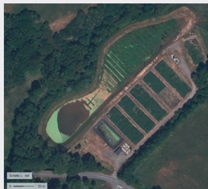
Photo aérienne de la station d'épuration, avec son système de phytoépuration (bassins plantés de roseaux)
